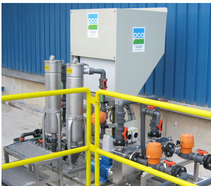
Unité de filtration et neutralisation du PH. (Foto's PCA Water)
