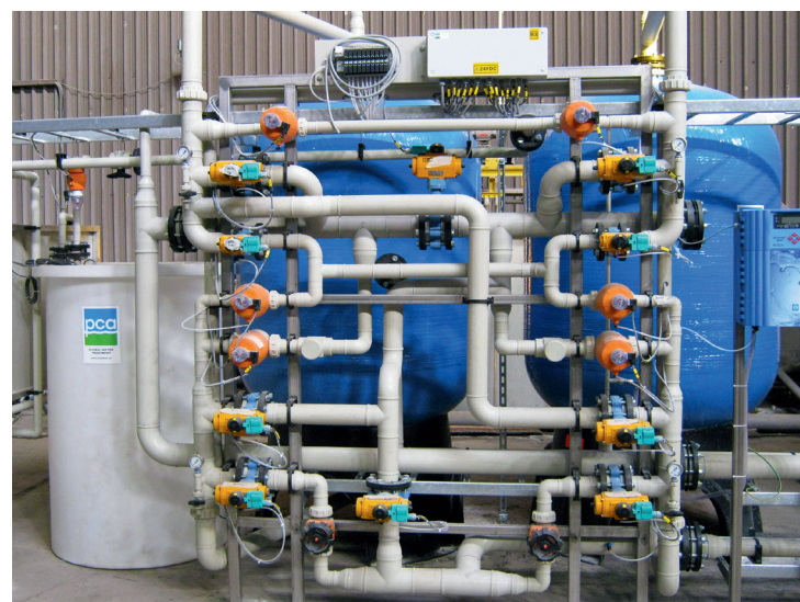
Installatie met zandfilter en waterverzachter.
